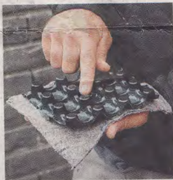
Un géotextile puis le plastique
